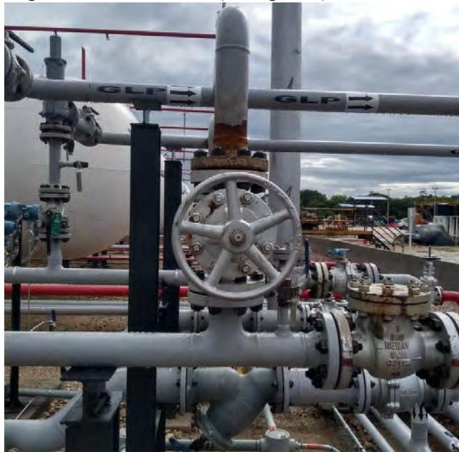
Figura 5. Válvula de recirculación.
