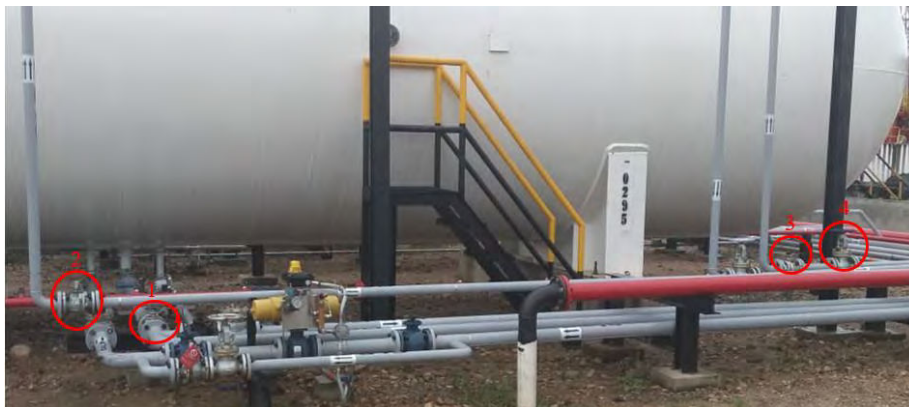
Figura 1. Líneas de entrada y salida de bala de GLP
