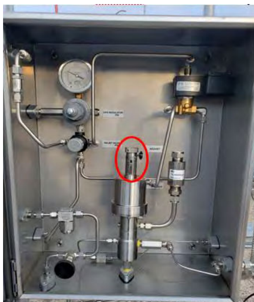
Figura 7. Sistema de dosificación de mercaptano
