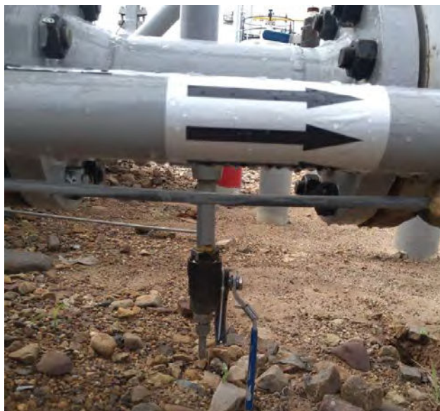
Figura 4. Válvula de recirculación por sobre presión
