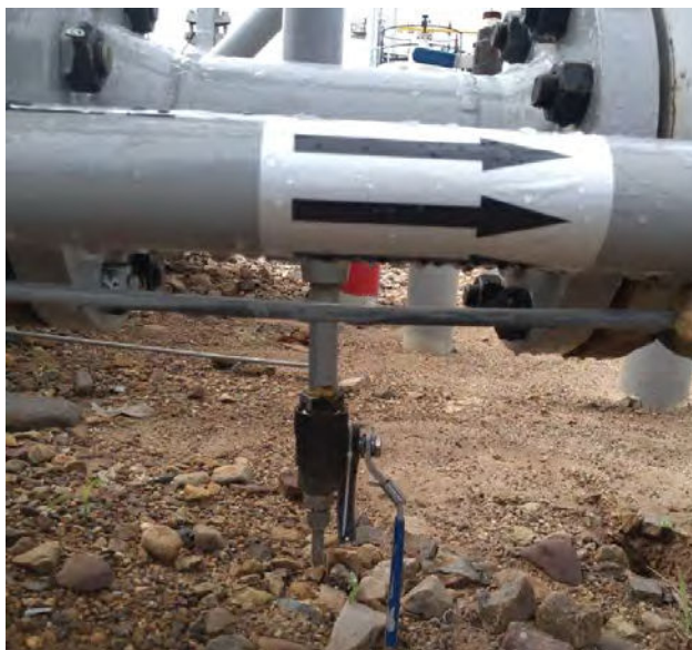
Figura 4. Válvula de recirculación por sobre presión
