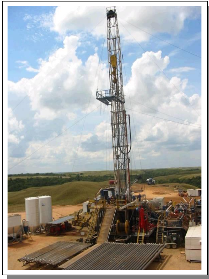
Fotografía 1-4 Sistema de potencia y levantamiento
