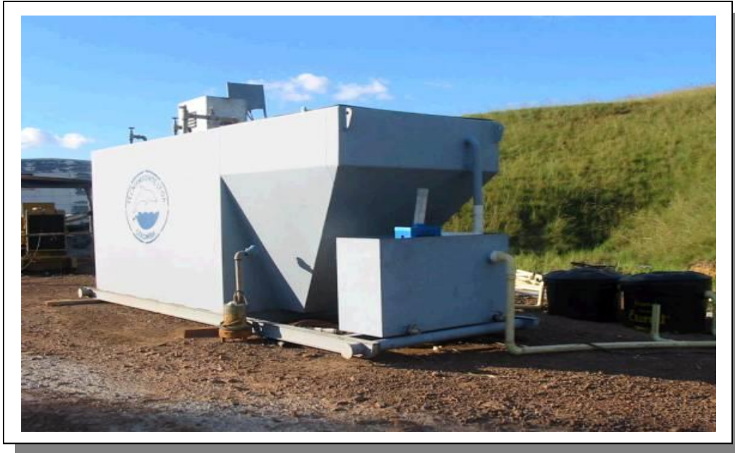
Fotografía 1-3 Ilustración de una unidad de lodos activados tipo “Red Fox”
