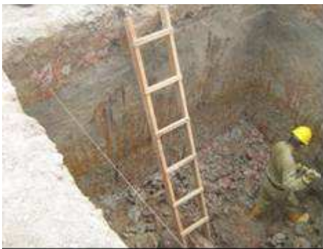
Fotografía 2. 5. Excavación mecánica y posterior perfilado manual del cellar.
