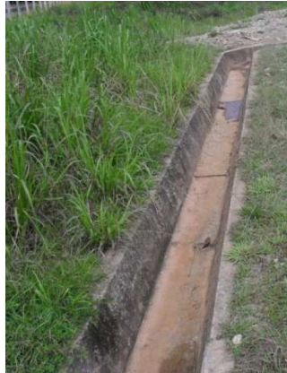
Fotografía 2. 38 Canal Perimetral en la Localización
