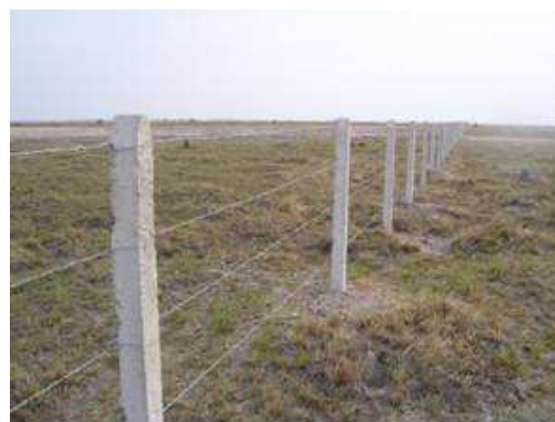
Fotografía 2. 22. Cerco una vez instalados los 4 hilos de alambre de púas.
