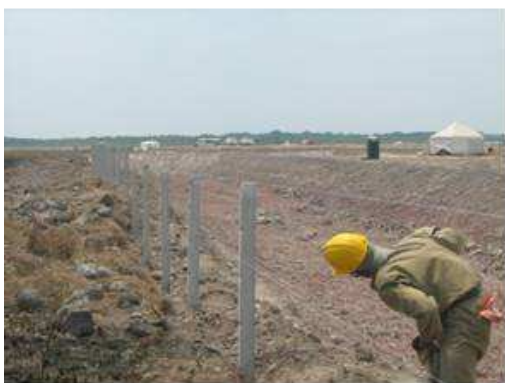
Fotografía 2. 21. Alineamiento de los postes de concreto.
