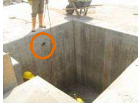
Fotografía 2. 8. Tubo metálico de 6” instalado por debajo de la placa del taladro para instalaciones eléctricas.
