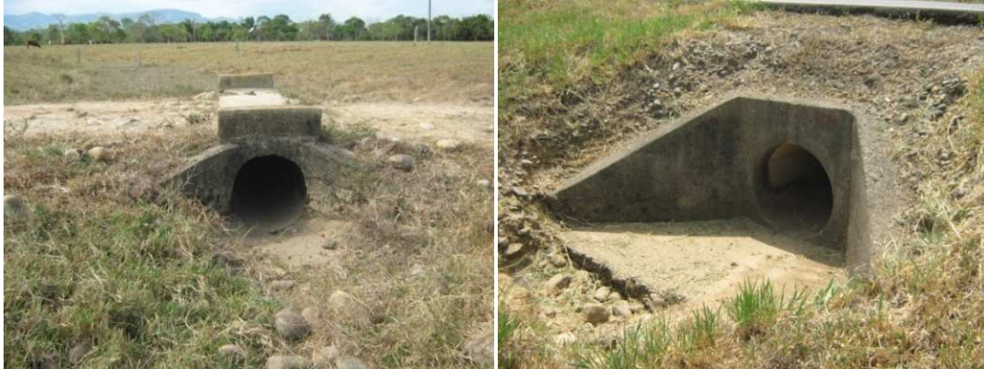
Fotografía 2. 2. Alcantarillas típicas en las vías del Bloque CPO4
