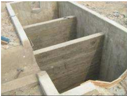
Fotografía 2. 15. Estructura una vez terminada.
