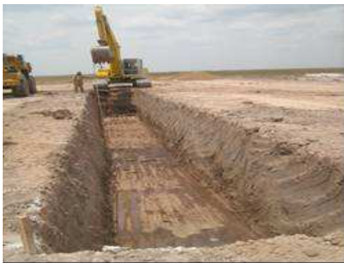
Fotografía 2. 9. Excavación mecánica de las piscinas de tratamiento de agua.
