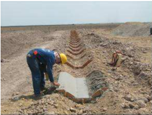
Fotografía 2. 17. Instalación de las guías de las cunetas trapezoidales
