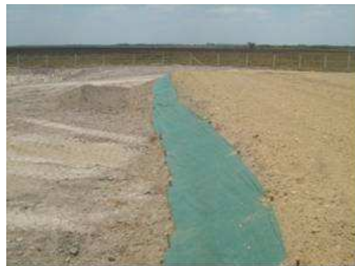
Fotografía 2. 25. Tramo del material instalado sobre talud de un terraplén.
