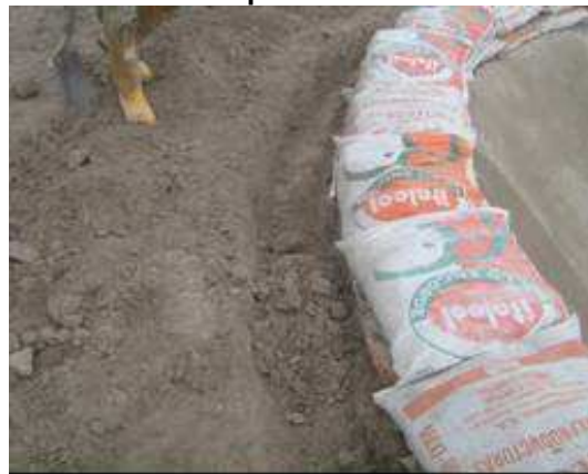
Fotografía 2. 29. Detalle de cuneta para anclaje de de geomembrana.
