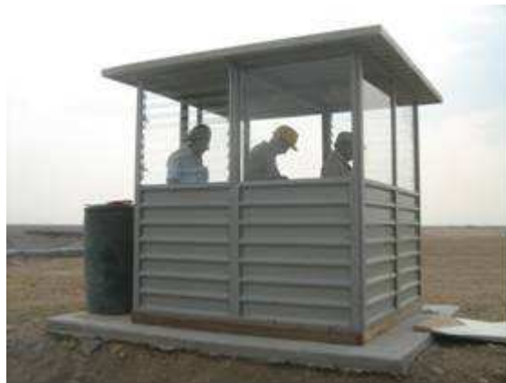
Fotografía 2. 23 . Caseta de celaduría prefabricada sobre placa de concreto reforzado.
