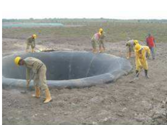
Fotografía 2. 27. Anclaje de geomembrana en la piscina VSP.
