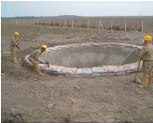
Fotografía 2. 28. Excavación de cuneta perimetral a la piscina VSP para anclaje de geomembrana.
