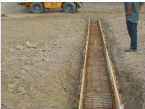
Fotografía 2. 19. Instalación de formaleta y malla de refuerzo.
