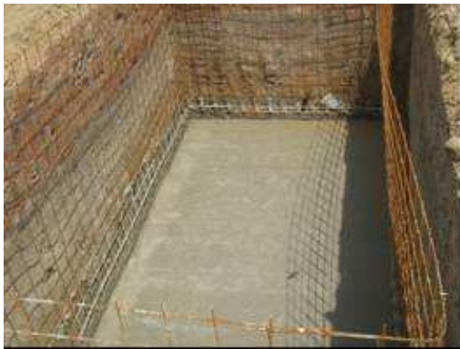
Fotografía 2. 13 Instalación de la malla de refuerzo.
