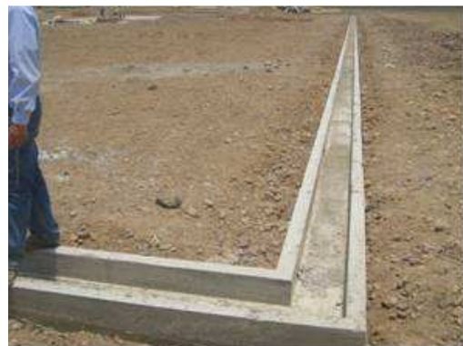
Fotografía 2. 20. Cárcamo una vez desencofrado.
