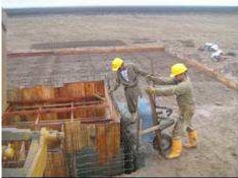
Fotografía 2. 7. Fundida de ambas estructuras monóticamente.
