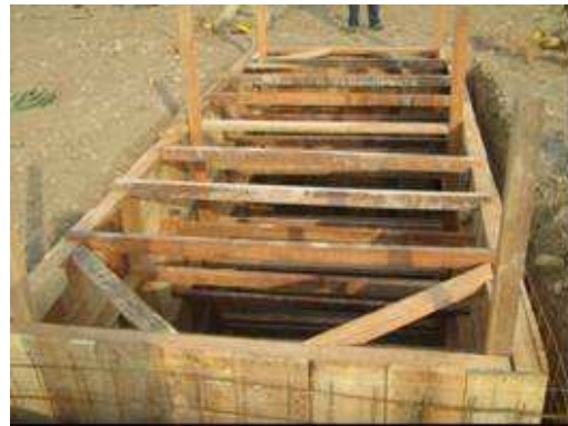
Fotografía 2. 14. Instalación de formaleta.
