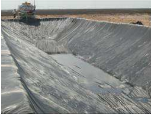
Fotografía 2. 11 . Piscina una vez instalada la geomembrana.
