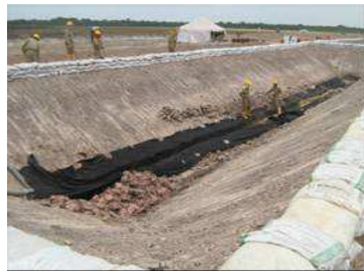
Fotografía 2. 10 Instalación de barrera de sacos de suelo en el perímetro para el anclaje de la geomembrana y del dren francés en el fondo.
