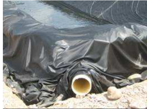
Fotografía 2. 12. Tubo de 8” que sirve para evacuar el agua que por nivel freático llega a caja de bombeo.
