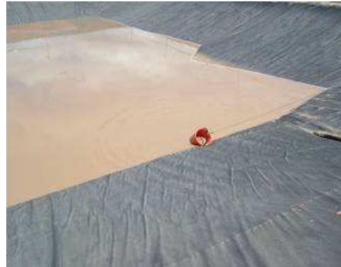
Fotografía 2. 37 Piscina de almacenamiento de cortes de perforación.
