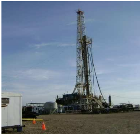
Figura 2. 29 Pozo durante la etapa de perforación. Se puede observar la tubería empleada para el revestimiento del mismo
