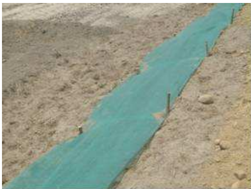
Fotografía 2. 24. Detalle de las estacas de madera fijando el geomatrix al suelo.
