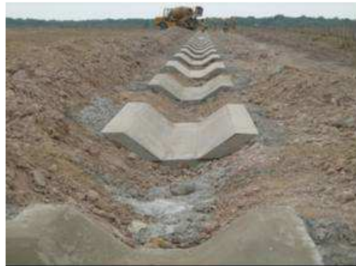
Fotografía 2. 18. Fundido en ajedrez de tramos de 2.5 m
