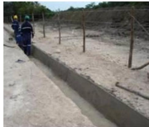
**Foto 2. 19. Construcción cunetas perimetrales**
