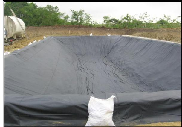
**Fotografía 2-58:** Instalación de geomembrana para la protección de suelos.
