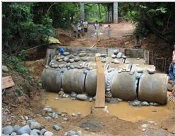
**Fotografía 2-45:** Tubería de 36" de diámetro atracadas en concreto.
