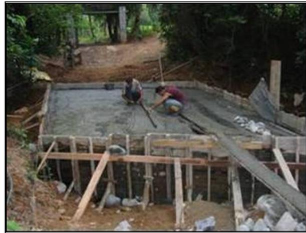
**Fotografía 2-46:** Placa de rodadura en concreto de 3000 Psi reforzado.
