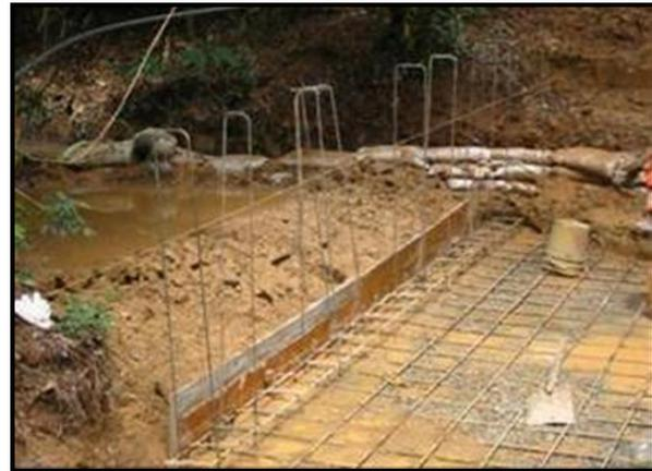
**Fotografía 2-44:** Excavación de fondo y arme de la estructura para la fundición de la placa de fondo.
