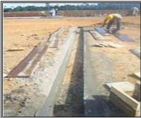
**Fotografía 2-55:** Obra típica de cunetas perimetrales en áreas operacionales.
