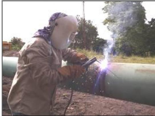
**Fotografía 2-73:** Soldadura de juntas.
