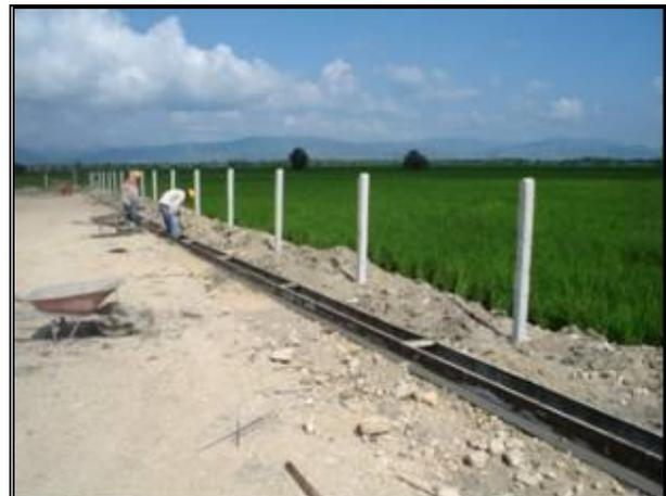
**Fotografía 2-56:** Obra típica de cunetas perimetrales para aguas lluvias.
