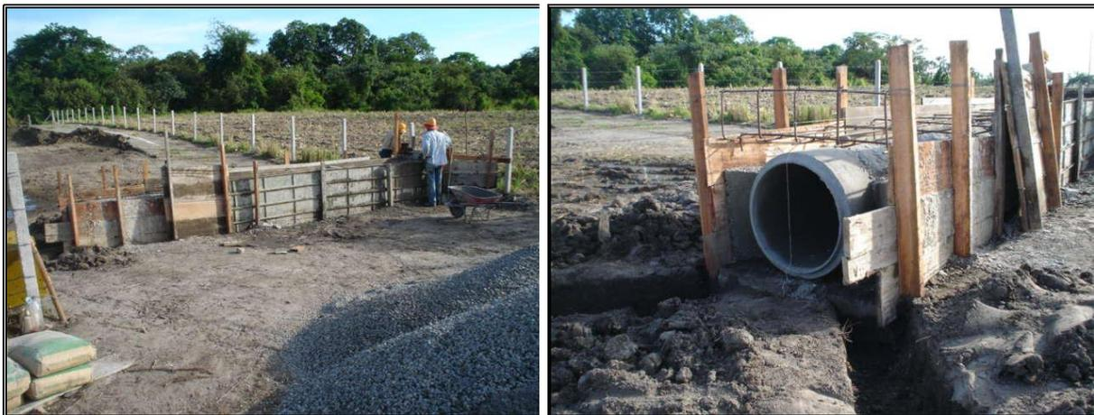
**Fotografía 2-41 y 2-42:** Proceso constructivo de una alcantarilla de 36" para drenaje de aguas lluvias.
