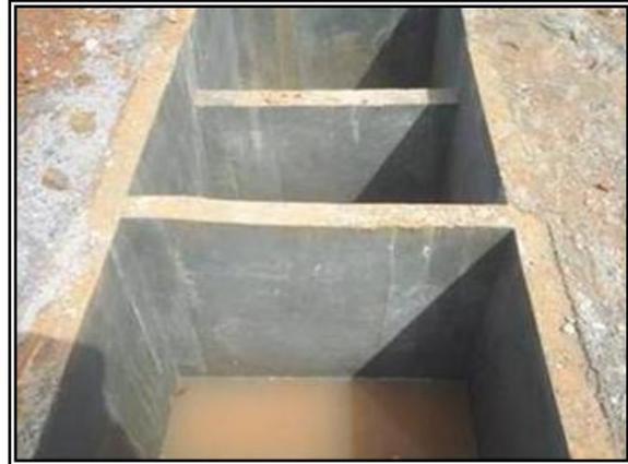
**Fotografías 2-51 y 2-52:** Obras típicas de construcción de skimmer.
