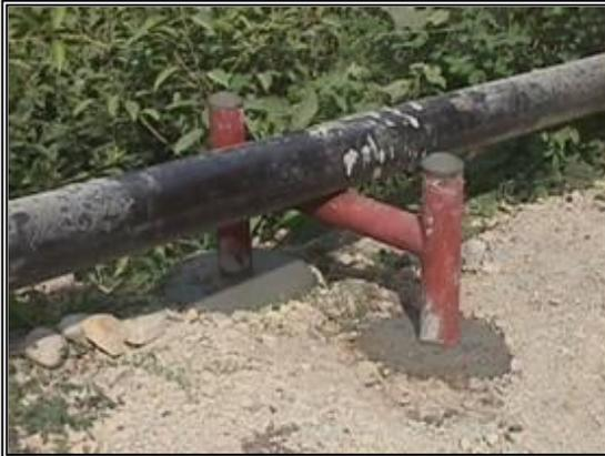
**Fotografía 2-77:** Equipo para sostener la tubería (marcos H).
