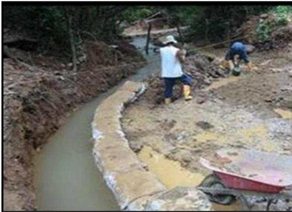
**Fotografía 2-43:** Construcción de un canal para el desvío temporal del flujo del cuerpo de agua.
