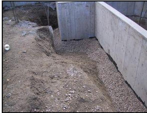
**Fotografía 2-60:** Muros de contención estándar para tanques.
