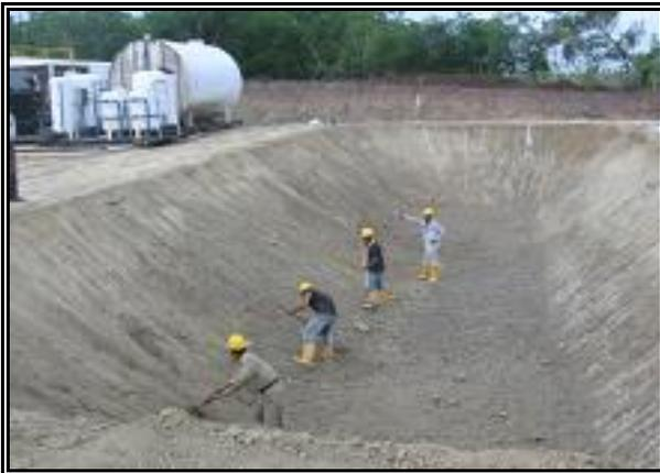
**Fotografía 2-57:** Obras típicas para la construcción de piscinas de tratamiento.
